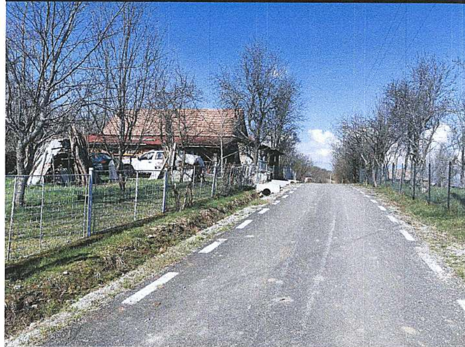
Drum de acces intravilan (aprox. 20 m de zona studiată)
